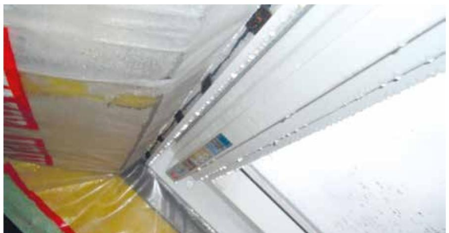
*Abb. 1 – Kondensat durch Baufeuchte: Putz oder Estrichfeuchte schlägt sich auf den Bauteiloberflächen in Form von Wassertropfen nieder. Sowohl am Dachflächenfenster, als auch an der Dampfsperre kommt es zu einer massiven Kondensatbildung.*
