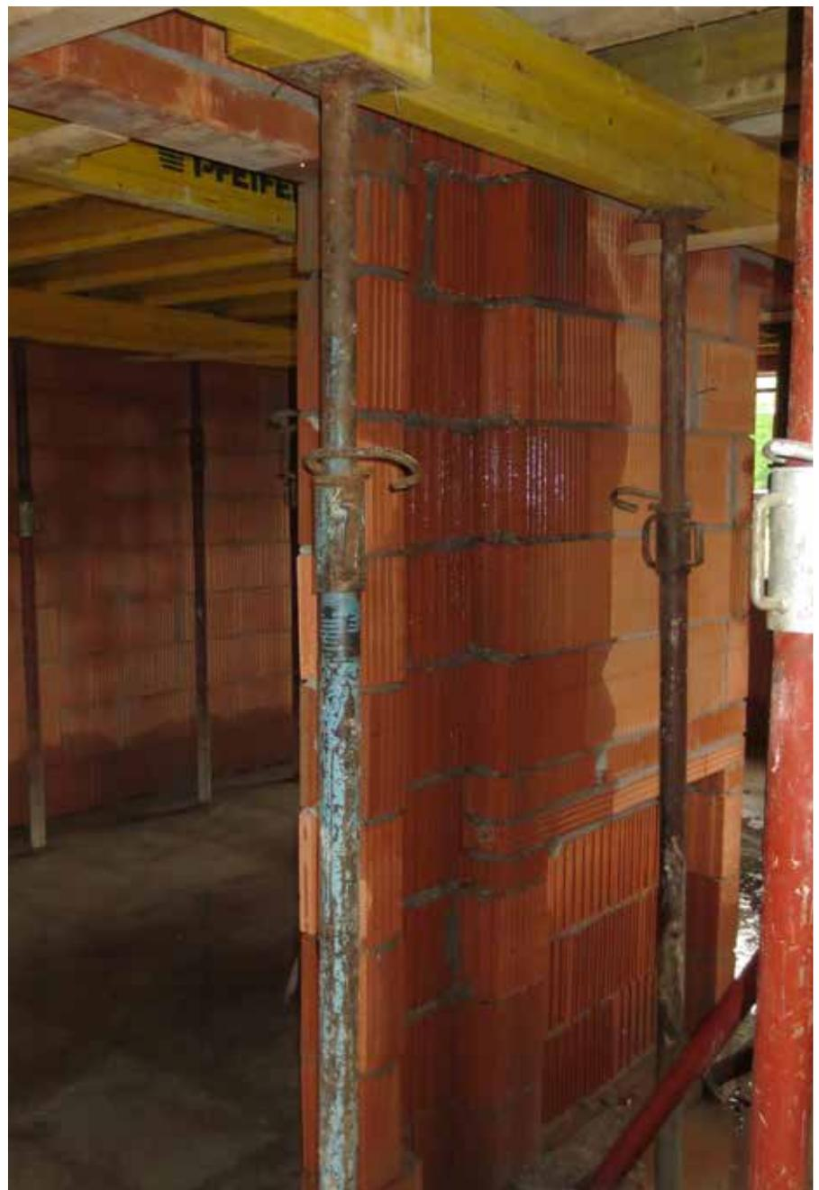
Abb. 3: Tagwasser kann in Mauerwerk zu hohen Feuchtegehalten führen. Wird diese Durchfeuchtung nicht gewissenhaft getrocknet ist Neubauschimmel kaum vermeidbar. Folgegewerke sollten ggf. Bedenken anmelden.
