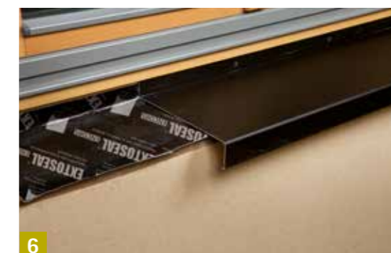
6 Fensterbank montieren
