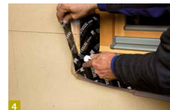
4 Senkrechte Überstände abschneiden
