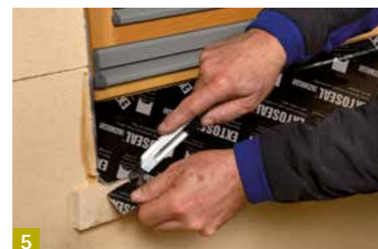
5 Waagerechten Überstand abschneiden
