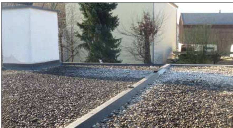
Auswirkung eines Wanderschattens von einem Kamin auf einem Flachdach
