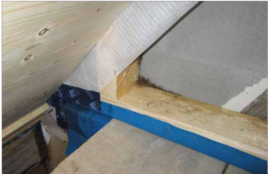
Durchgängige Luftdichtung am Deckenaufleger
