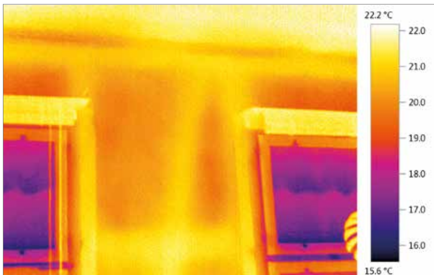
Thermografie Außenwand: Thermografie einer Fachwerkwand vor der Sanierung
