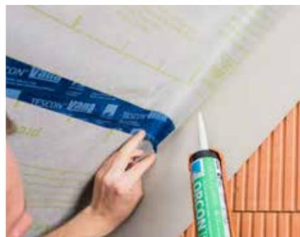
Anschlusskleber für Luftdichtungsbahnen innen,
