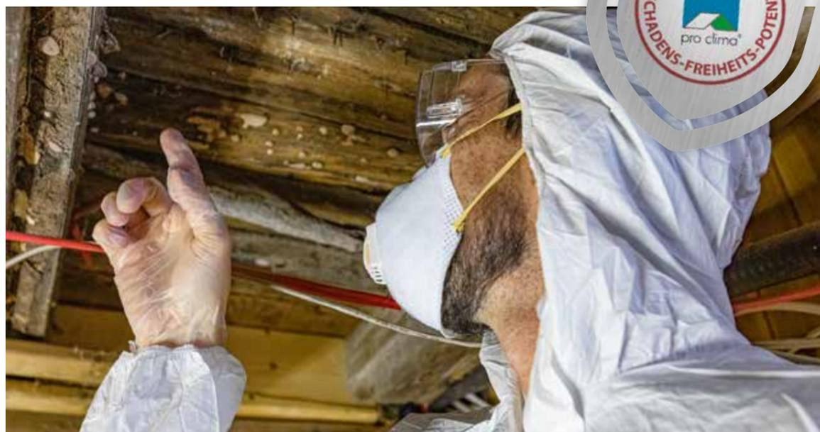
Wer bauschadensfreie Konstruktionen schaffen und dauerhaft erhalten möchte, muss diese vor Feuchtigkeit schützen. Den Schutz vor Wind, Regen und Schnee von außen übernimmt die Winddichtungsebene, z. B. eine Unterdeck- oder Wandschalungsbahn. Damit kein Tauwasser von innen in die Dämmung eindringen kann, ist eine Dampfbrems- und Luftdichtungsebene zwingend erforderlich. Hier jedoch können sich schon kleine Undichtheiten negativ auswirken.
