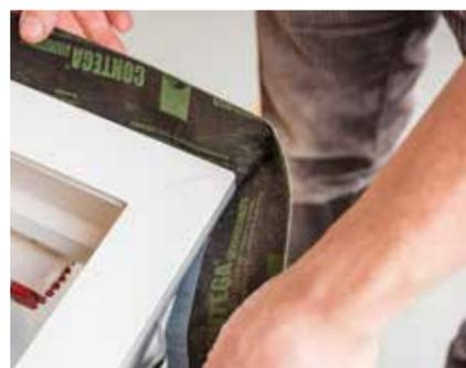
Eckschleife herstellen (Länge: 1,5 x Fugenbreite).
