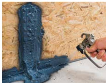
Luftdichtes Übersprühen von Befestigungswinkeln,
