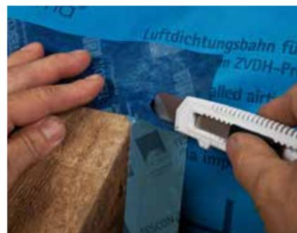
Bahn mit TESCOCON VANA luftdicht am Sparren anschließen.
