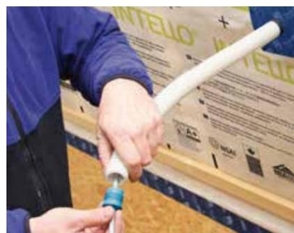
STOPPA dichtet Kabel in Leerrohren ab.
