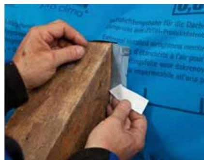
Trennfolie ablösen: Bahn und Sparren luftdicht verkleben.
