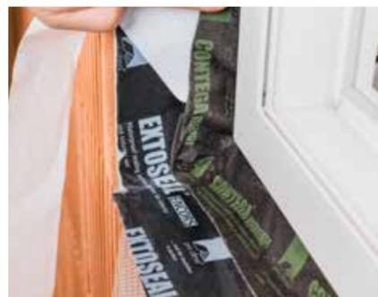
In Ecken luft- bzw. schlagregendicht verkleben.
