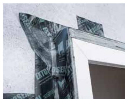
Anschluss von Fenstern im Mauerwerks- und Betonbau.
