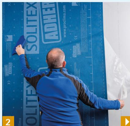
Alternativ möglich: vertikale Verlegung. Bahn mit PRESSFIX XL immer fest anreiben.
