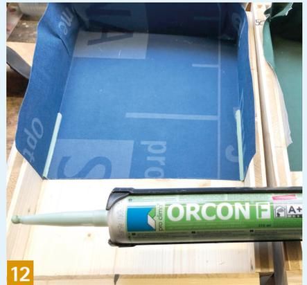
**12** Bahnenüberlappung an aufgehenden Bauteilen zusätzlich mit ORCON F dichten.
