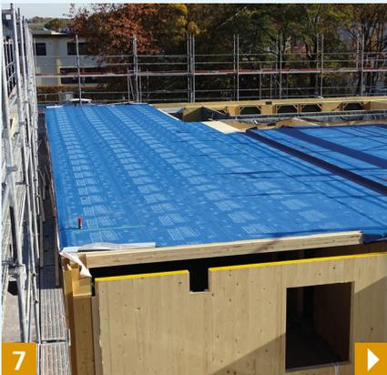
Die nächste Bahn mit 15 cm Überlappung auf die bestehende Bahn ankleben.
