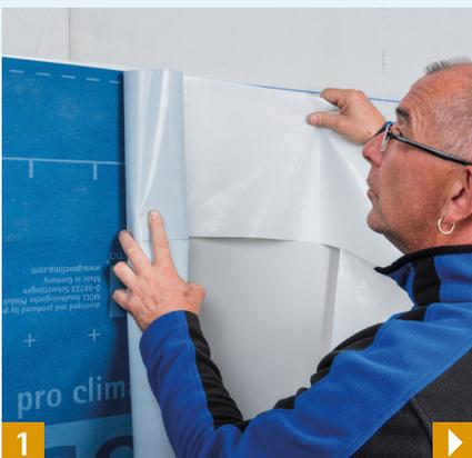
Die Bahnen werden i.d.R. horizontal verlegt.
