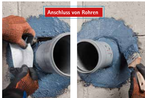
Verschließen von Löchern bis max. 70 mm Durchmesser
