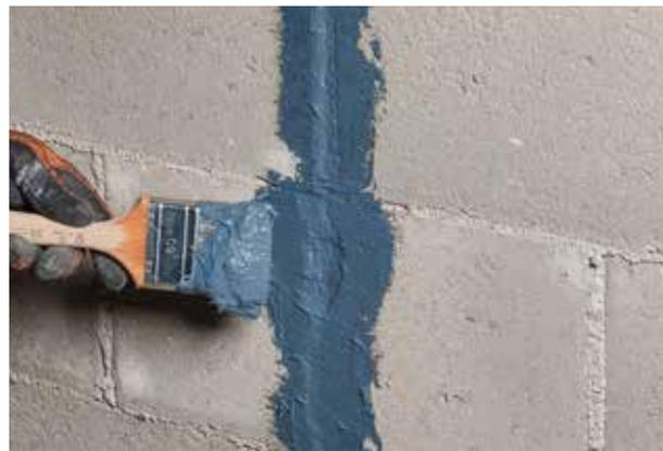
Mit dem faserarmierten AEROSANA VISCONN FIBRE ist die Luftdichtheit breiter Risse leicht und zeitsparend herzustellen – sowohl im Streich- als auch im Sprühverfahren (AEROFIXX).
