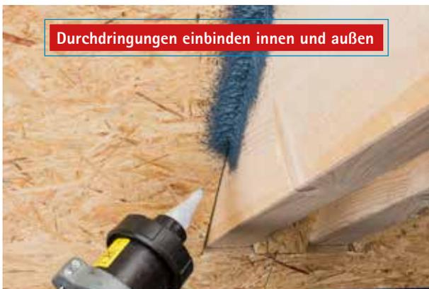
Einfaches luftdichtes Einbinden von Durchdringungen (z. B. Zangen oder Sparren bei der Dachsanierung von außen.)
