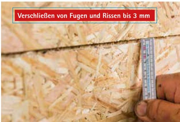
Leichtes Verschließen von Rissen oder Fugen durch Sprühen oder Streichen. Die Fehlstellen werden dazu mit AEROSANA VISCONN geflutet und übersprüht.
