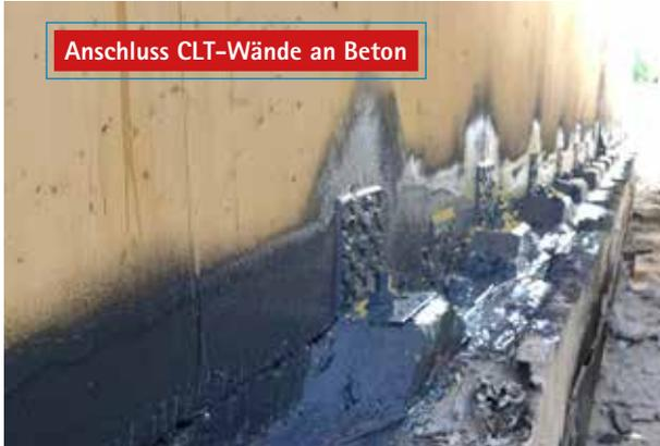
Luftdichter Übergang von CLT-Elementen auf z. B. Betonplatten inkl. schwieriger Geometrien (z. B. Winkel). Die Deckschicht der Elemente muss dazu luftdicht sein. Quellmörtel können einfach eingebunden werden.
