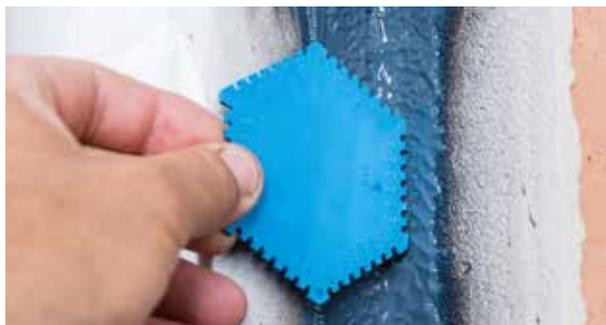
Während des Trocknens wechselt AEROSANA VISCONN die Farbe von blau zu schwarz. AEROSANA VISCONN white hat keinen Farbumschlag. Der Feuchte Film ist vor Feuchtigkeit (z. B. Regen) bis zur vollständigen Durchtrocknung zu schützen. Unmittel-
