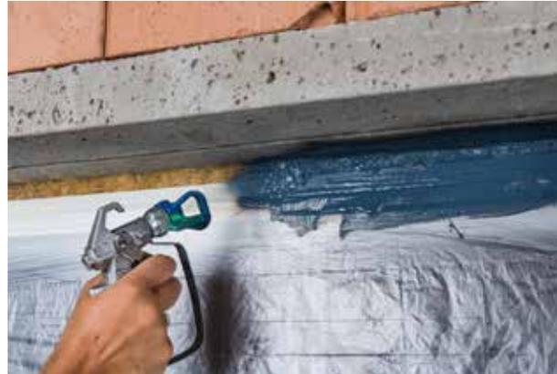
Herstellen der luftdichten Innen- und schlagregendichten Außenanschlüsse im Streich- oder Sprühverfahren. Flexibel einsetzbar auf faserförmigen Dämmstoffen (z. B. Hanf- oder Schafwolle) sowie auf Ortschaum. Anschlüsse innen und außen nach IFT-Richtlinie MO-01/1:2007-01, Abs. 5 geprüft und bestätigt.
