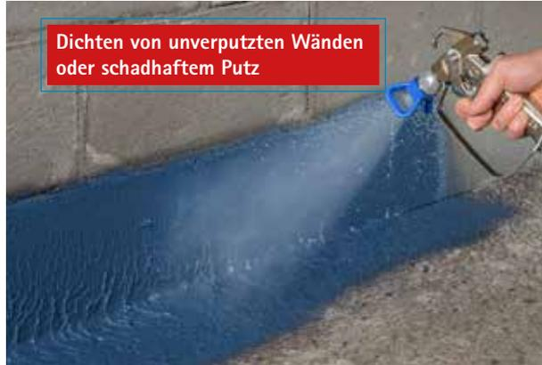
Herstellen der Luftdichtheit von unverputztem Mauerwerk.
