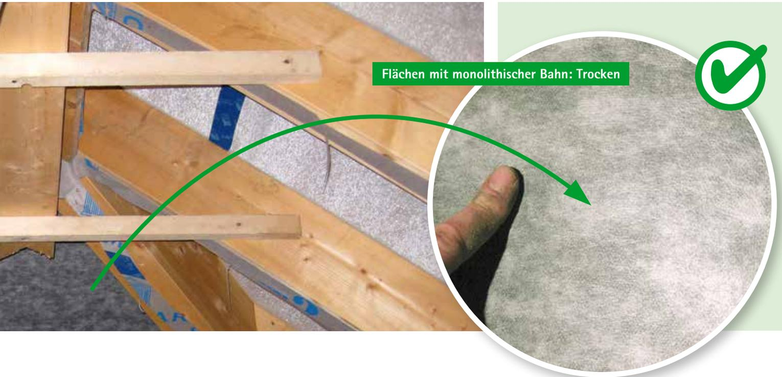
Flächen mit monolithischer Bahn: Trocken
