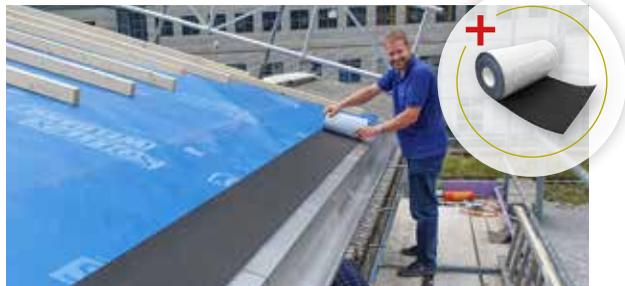
Traubahn zur Verlegung auf SOLITEX WELDANO für den offenen Traufabschluss mit Lochblech. Ermöglicht das Entwässern des Unterdachs in die Dachrinne.
