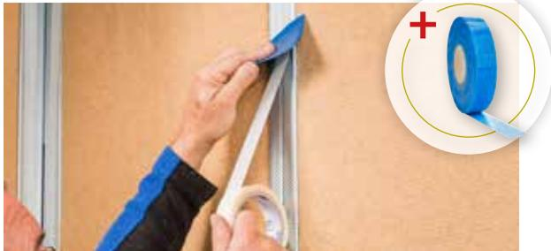
Für die feuchtgeschützte Verklebung von Unterdeck-, Unterspann- und Wandschalungsbahnen. Auch für die Befestigung von Dampfbremsen auf Metallprofilen geeignet.
