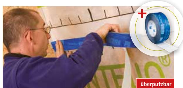
Für dauerhaft luftdichte und sichere Verklebung der Überlappungen von Folien und Vliesbahnen (Dampfbrems- und Luftdichtungsbahnen, Unterdeck- und Fassadenbahnen) und deren Anschlüsse. Auch für die Verklebung der Stoßfugen von Holzwerkstoffplatten geeignet.
