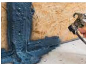
Anschluss Holzbauwände an Betonboden
