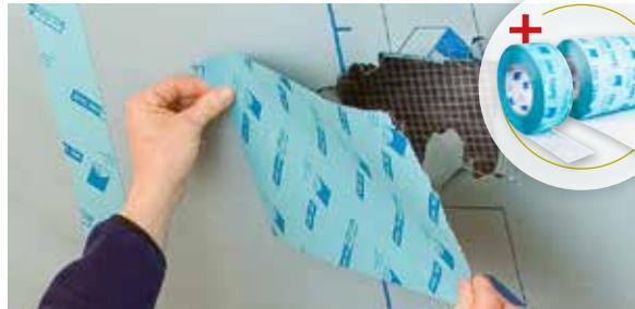
UNI TAPE: Für dauerhaft luftdichte und sichere Verklebung der Überlappungen von Dampfbrems- und Luftdichtungsbahnen und deren Anschlüsse im Innenbereich. Auch für die Verklebung der Stoßfugen von Holzwerkstoffplatten geeignet.
