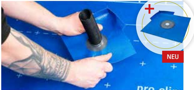
Sichere Ausführung von Rohrdurchdringungen im SOLITEX WELD-ANO-Unterdecksystem. Mit der vorgefertigten Manschette werden Rohrdurchführungen einfach, schnell und dauerhaft dicht hergestellt. Geeignet für Dachneigungen ab 5°.
