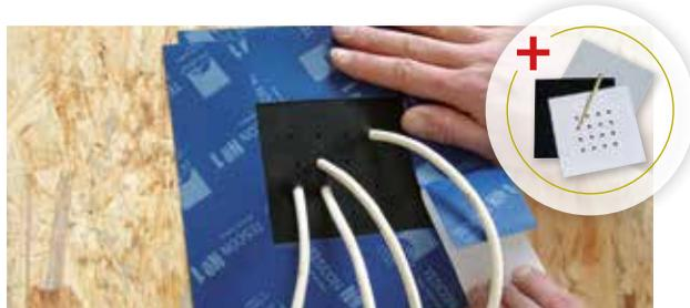
Für die schnelle und dauerhaft dichte Durchführung von bis zu 16 Kabel mit Durchmesser 4,8 bis 12 mm. Jede Manschette als komplettes Set inkl. Schablone und Stanzwerkzeug. Verklebung mit TESCON VANA oder TESCON INVIS.
