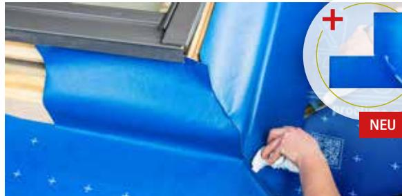
Sichere Ausführung von Dachfensterecken im SOLITEX WELDANO-Unterdecksystem. Das werkseitig vorverschweißte, diffusionsoffene Formteil kann mit dem System-Quellschweißmittel oder Heißluft materialhomogen mit der Unterdeckbahn SOLITEX WELDANO 3000 verbunden werden.
