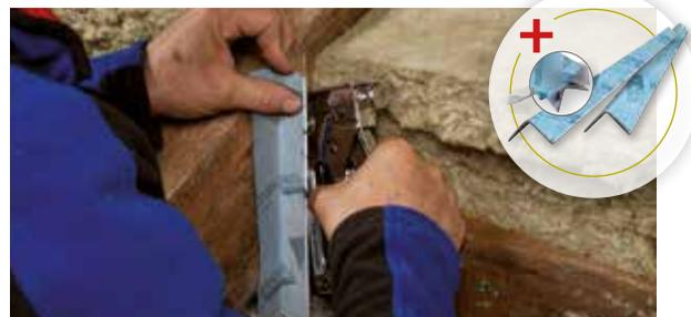
Schafft eine definierte Ebene für den einfachen und sicheren luftdichten Anschluss an eckige und leicht abgerundete Durchdringungen, z.B. bei der traufseitigen Sparrendurchführung bei Dachsanierungen von außen mit dem DASAPLANO-System, an sichtbare Zangenlagen im Steildachbereich oder an Deckenbalken geschossübergreifender Innendämmungen von Wänden.
