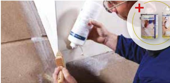
Zur Vorbereitung bzw. Ertüchtigung des Untergrundes für die anschließende Verklebung mit pro clima Klebebändern, wie z. B. TESCON VANA, TESCON PROTECT und Klebebänder der EXTONSEAL-Familie. Für Holz, Holzfaserverleimungen, Mauerwerk, Dach, Wand und Bodenplatten geeignet.
