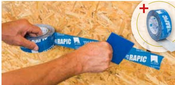
Luftdichte Verklebung von Dampfbremsen und Luftdichtungsbahnen sowie von luftdichten, glatten und harten Holzwerkstoffplatten.
