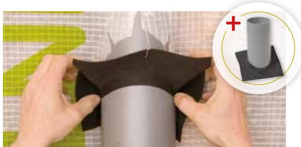
Für die schnelle und dauerhaft dichte Durchführung von Rohren durch die Luftdichtungsebene. Einsatz auch im Außenbereich, z. B. bei Unterdeckungen oder Sanierungs-Dampfbremsen. Verklebung mit TESCON VANA oder TESCON INVIS.
