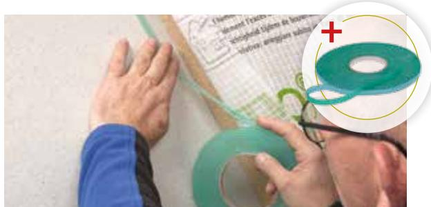
Lösemittelfreier, dauerhafter, elastischer, frostsicherer Luftdichtungskleber von der Rolle für den Anschluss von Dampfbremsen und Dampfsperren.
