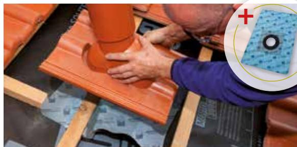
Für den schnellen, dauerhaft winddichten und wasserführenden Anschluss der Unterdeckung bzw. Unterspannung unter dem Durchgangsziegel. Bei Bedarf kann die Manschette flexibel angepasst werden. Das Klebepatch ist diffusionsfähig.
