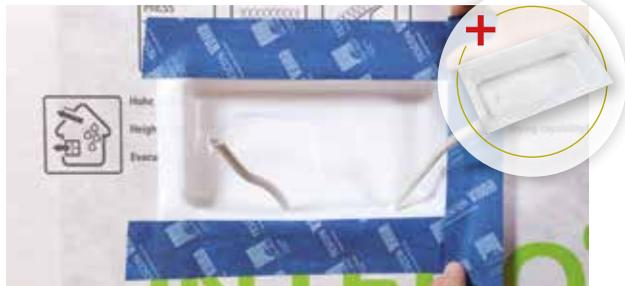
Bei Konstruktionen ohne Installationsebene kann die INSTAABOX Raum für Gerätedosen o.ä. schaffen. Dazu wird sie auf der vorhandenen Dampfbrems- und Luftdichtungsebene angebracht und mit dieser luftdicht verbunden. Die INSTAABOX kann sowohl bei Innen- als auch bei Außenwänden eingesetzt werden.
