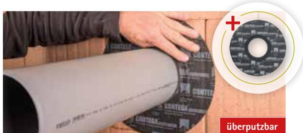
Für den schnellen und dauerhaft dichten Anschluss von Rohrdurchführungen durch Wände und Decken aus Mauerwerk bzw. Beton, sowie auf Holzfaser- und Holzwerkstoffplatten, innen und außen.
