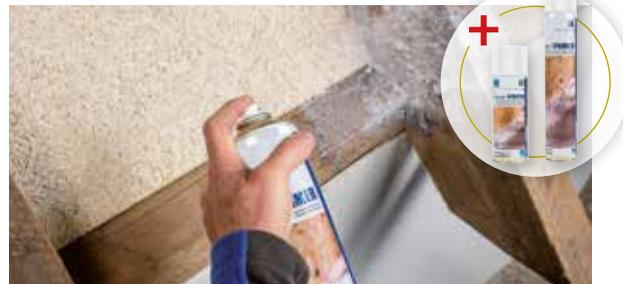
Zur Vorbereitung bzw. Ertüchtigung des Untergrundes für die anschließende Verklebung mit pro clima Klebebändern, wie z. B. TESCON VANA, TESCON PROTECT und Klebebänder der EXTOSEAL-Familie. Für Holz, Holzfaserverplatten, Mauerwerk, Dach, Wand und Bodenplatten geeignet.
