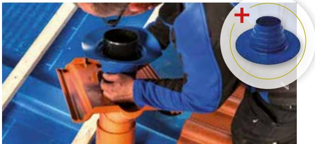
Sichere Ausführung von Rohrdurchdringungen im SOLITEX WELDANO-Unterdachsystem. Mit der vorgefertigten Manschette werden Rohrdurchführungen einfach, schnell und dauerhaft dicht hergestellt. Geeignet für Dachneigungen von 3° bis 25°.
