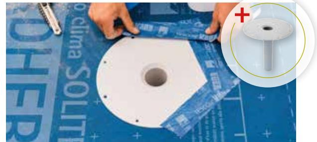
Formteil für die vertikale Entwässerung durch das Decken- oder Dachpaket während der Bauphase. Einbau mit Anschluss an ein Rohr- oder Schlauchsystem zur temporären Wasserableitung.
