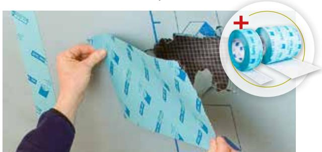
UNI TAPE: Für dauerhaft luftdichte und sichere Verklebung der Überlappungen von Dampfbremse- und Luftdichtungsbahnen und deren Anschlüsse im Innenbereich. Auch für die Verklebung der Stoßfugen von Holzwerkstoffplatten geeignet.
