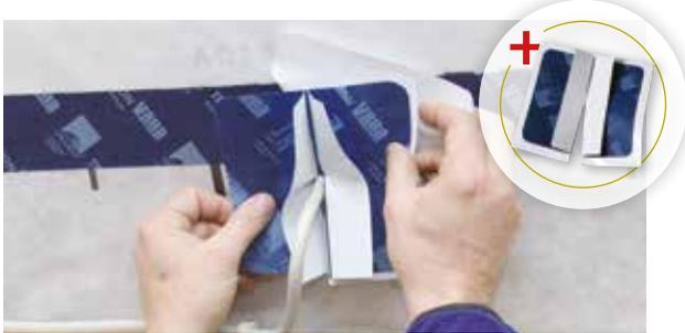
Für die schnelle und dauerhaft sichere Einbindung von bereits eingebauten Kabeln und Leerrohren bis 20 mm.
