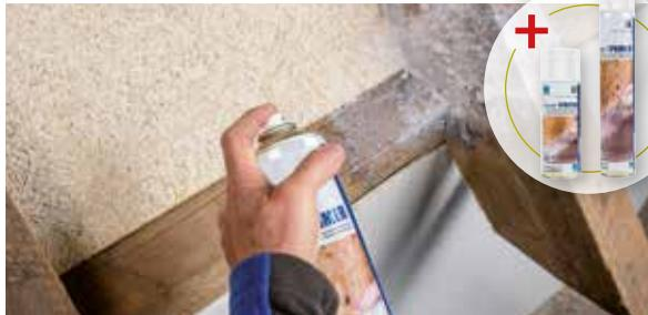
Zur Vorbereitung bzw. Ertüchtigung des Untergrundes für die anschließende Verklebung mit pro clima Klebebändern, wie z. B. TESCON VANA, TESCON PROTECT und Klebebänder der EXTONSEAL-Familie. Für Holz, Holzfaserverplatten, Mauerwerk, Dach, Wand und Bodenplatten geeignet.
