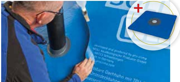
Sichere Ausführung von Rohrdurchdringungen im SOLITEX WELDANO-Unterdachsystem. Mit der vorgefertigten Manschette werden Rohrdurchführungen einfach, schnell und dauerhaft dicht hergestellt. Geeignet für Dachneigungen von 3° bis 50°. Um eine dauerhafte Dichtheit auch bei Rückstauwasser zu erreichen, muss an den entstehenden Flansch ein SOLITEX WELDANO-S 3000 Streifen angeschweißt werden (siehe Verarbeitungshinweise).
