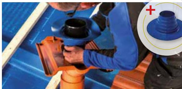
Sichere Ausführung von Rohrdurchdringungen im SOLITEX WELDANO-Unterdachsystem. Mit der vorgefertigten Manschette werden Rohrdurchführungen einfach, schnell und dauerhaft dicht hergestellt. Geeignet für Dachneigungen von 3° bis 25°.
