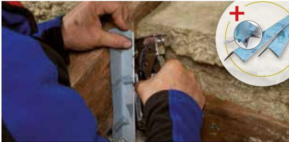
Schafft eine definierte Ebene für den einfachen und sicheren luft-dichten Anschluss an eckige und leicht abgerundete Durchdringungen, z. B. bei der traufseitigen Sparrendurchführung bei Dachsanierungen von außen mit dem DASAPLANO-System, an sichtbare Zangenlagen im Steildachbereich oder an Deckenbalken geschossübergreifender Innendämmungen von Wänden.
