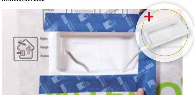
Bei Konstruktionen ohne Installationsebene kann die INSTAABOX Raum für Gerätedosen o.ä. schaffen. Dazu wird sie auf der vorhandenen Dampfbrems- und Luftdichtungsebene angebracht und mit dieser luftdicht verbunden. Die INSTAABOX kann sowohl bei Innen- als auch bei Außenwänden eingesetzt werden.
