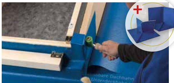
Sichere Ausführung von Inneneck-/Außeneckanschlüssen im SOLITEX WELDANO-Unterdachsystem. Das werkseitig vorverschweißte, diffusionsoffene Formteil kann mit dem System-Quellschweißmittel oder Heißluft material-homogen mit der Unterdachbahn SOLITEX WELDANO verbunden werden.
