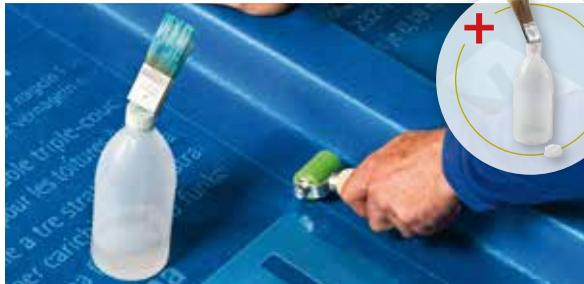
Für besonders schnelles und einfaches Auftragen des Quellschweißmittels WELDANO TURGA.
