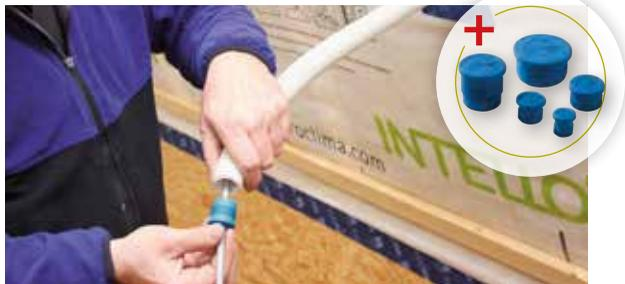
Für die schnelle und dauerhaft sichere luftdichte Einbindung von Kabeln in Leerrohre. Für den luftdichten Anschluss von Leerrohren an die Dampfbrems- und Luftdichtungsebene stehen Leerrohrmanschetten (z. B. ROFLEX 20 oder ROFLEX 20 multi) zur Verfügung.
