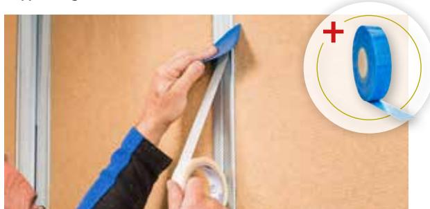
Für die feuchtegeschützte Verklebung von Unterdeck-, Unterspann- und Wandschalungsbahnen. Auch für die Befestigung von Dampfbremse auf Metallprofilen geeignet.
