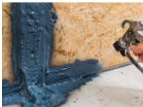
Anschluss Holzbauwände an Betonboden
